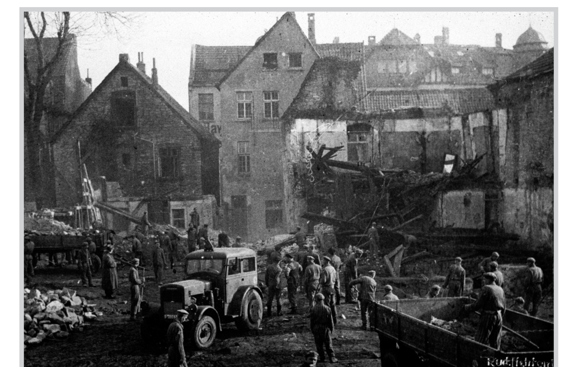
Häftlinge bei Räumarbeiten an der Redlingerstraße. Hier errichteten Strafe- fangene aus dem Lager Esterwegen VII un- mittelbar neben einem Schulgebäude den Redlingerbunker. [Quelle: Medienzentrums Osnabrück]
