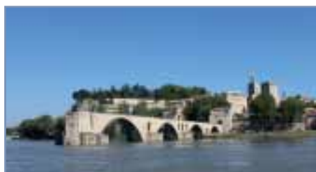
Blick auf die legendäre Brücke von Avignon
