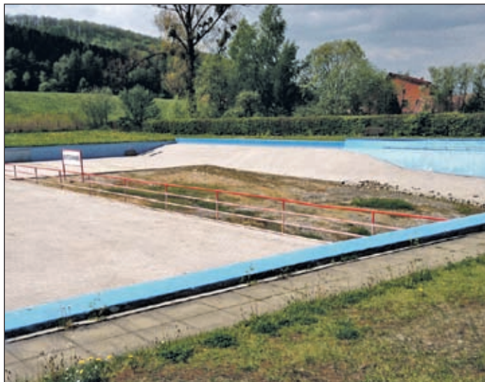
Blick in das leere Becken des Bades, dass bis auf einige lose Pflastersteine keine offensichtlichen Mängel erkennen lässt. Foto: bj
