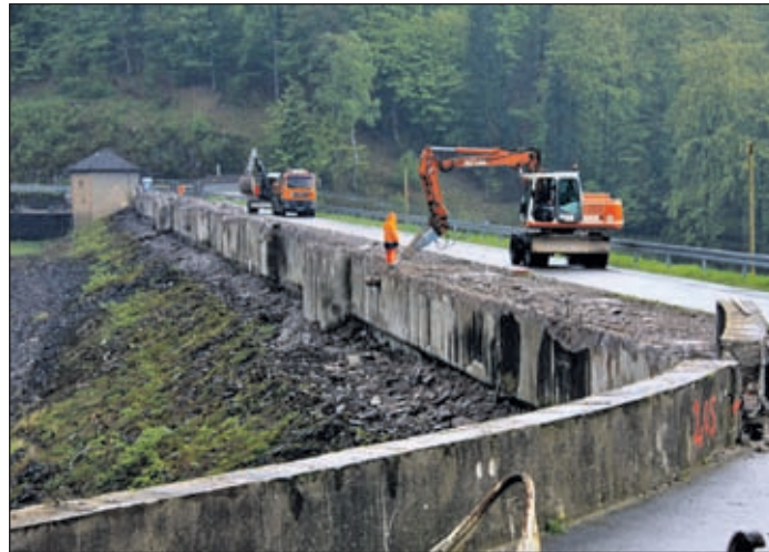
Odertalsperre, deren Staumauer durch die Harzwasserwerke derzeit aufwendig saniert wird.
