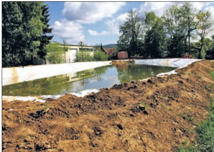
Das riesige Absetzbecken für den abgesaugten Schlamm.
